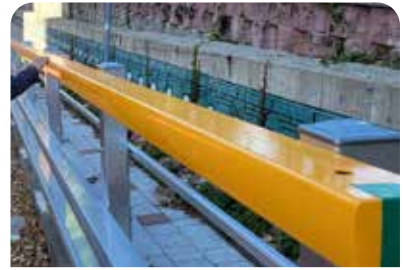
어린이 보호구역 교통안전시설물 설치 (방호울타리)
