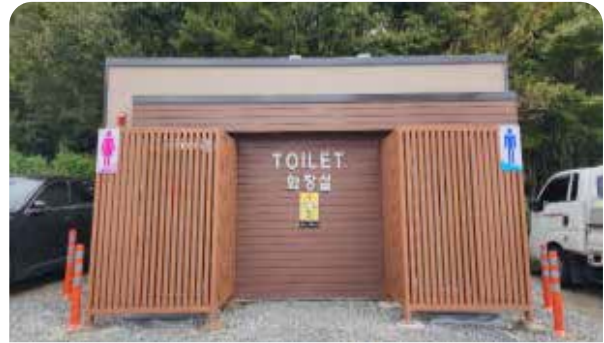
덕하시장 공중화장실 설치공사
