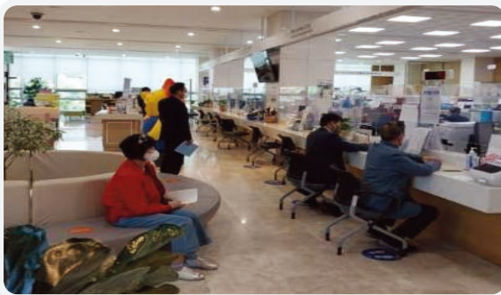
민원창구 투명 가림막 설치
